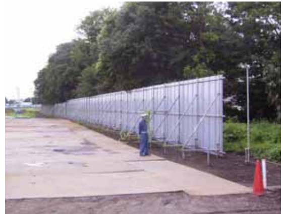
写真 仮囲い設置状況
