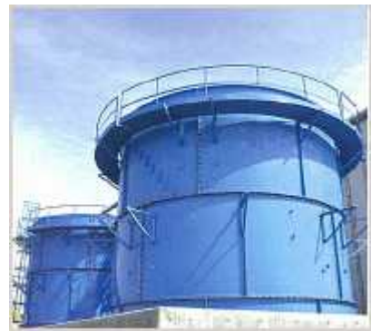
処理水の貯留槽
