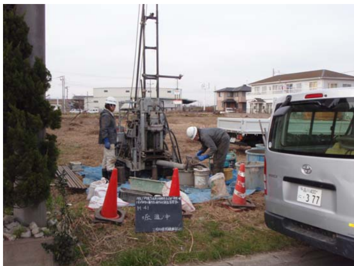
ABトラック南西地域 新規地下水モニタリング孔設置工 事状況（1月28日）
