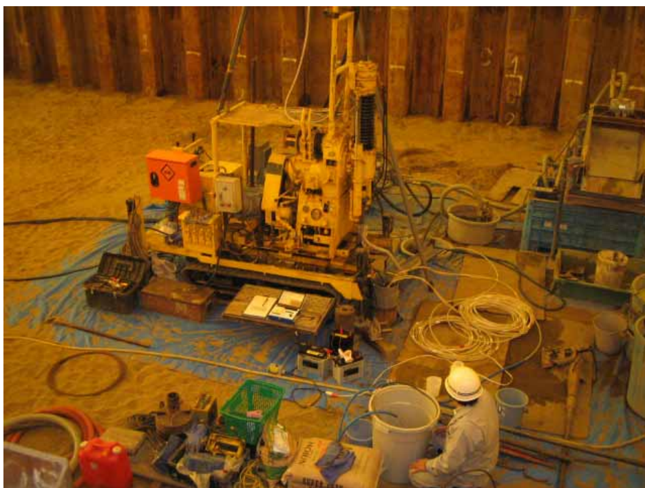
現在設置中の掘削調査地点の状況
