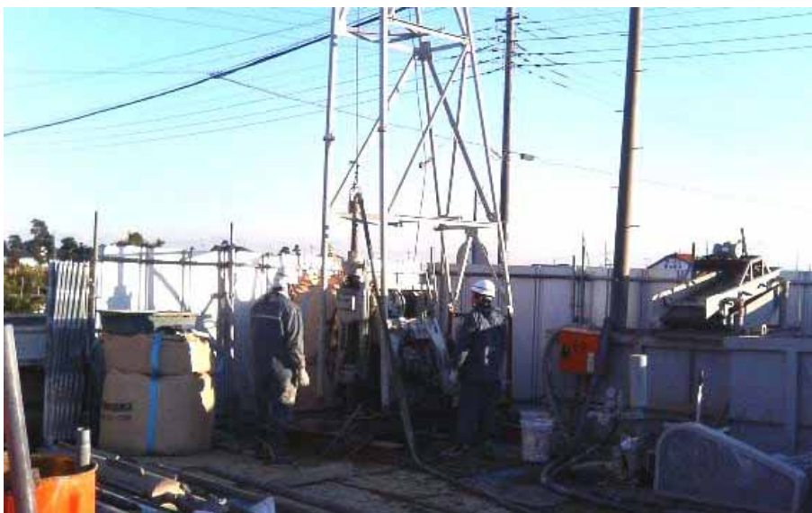
現在設置中のABトラック南西地域揚水井戸
