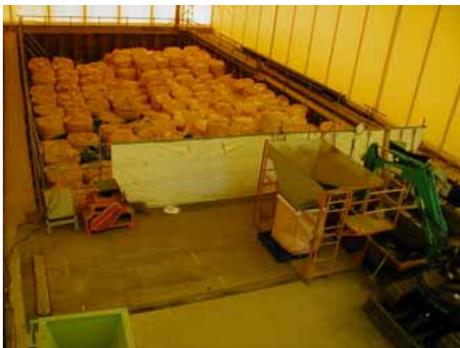
掘削テントの保管状況(分級前)
