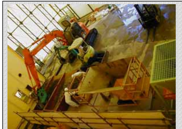
コンクリート様の塊の粗破碎状況
