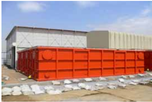
水処理プラントの外観 (手前:処理槽、中:建屋、奥:掘削現場テント)
