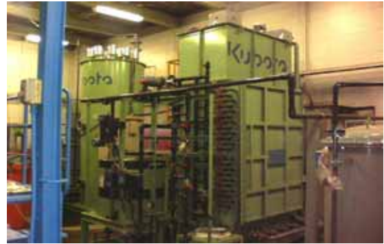
建屋内部 (手前:凝集膜ろ過装置、奥:光化学分解装置)
