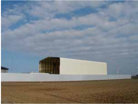
仮設テント南側
