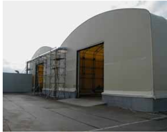
保管テント東側
