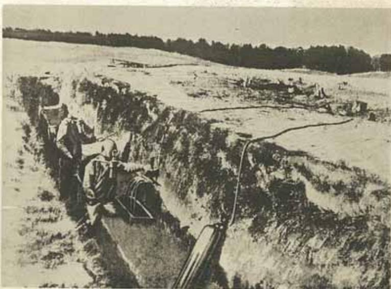
歐洲大戰に於て第一線の塹壕に設置せる露軍ガス放射筒 (C. K.)
