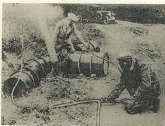
發電所の周間に多くの枝管を圍らし發煙剤を入れたる罐より噴射せしむ (科學知識 1932)
