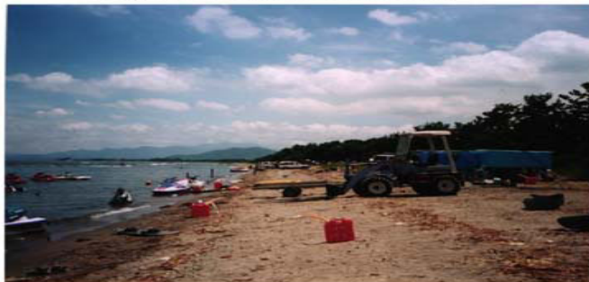
重機による水上バイク搬入
