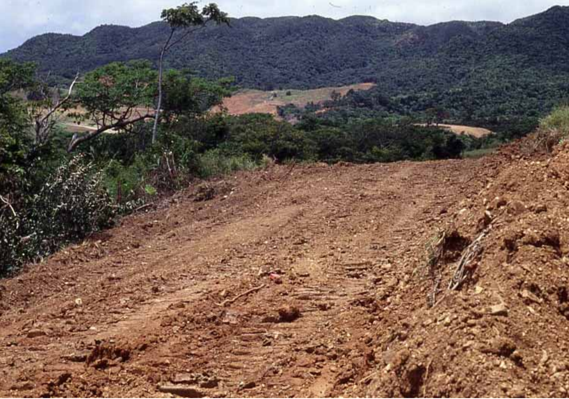
道路建設 Road construction
