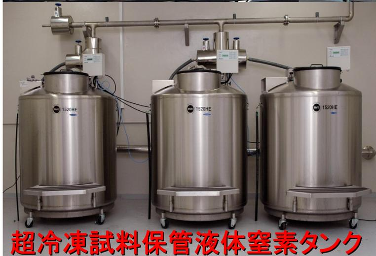
超冷凍試料保管液体窒素タンク
