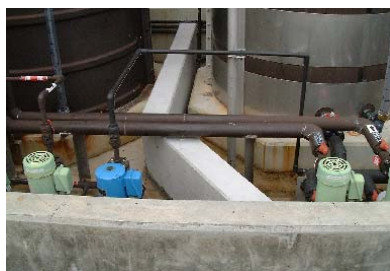
防液堤及び防護壁の設置
