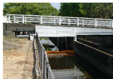
オイルフェンスの設置
