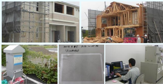
対象建屋の解体作業と大気浮遊塵の捕集 (2020年5月～8月)
