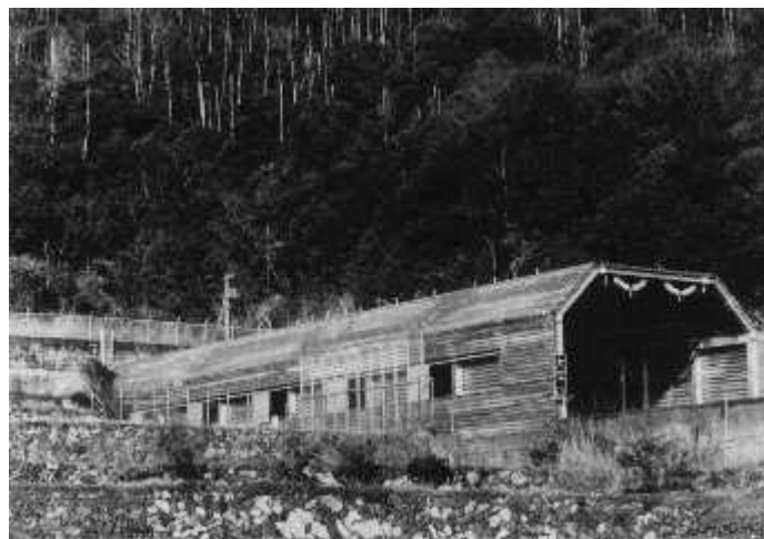
図 4 長さ 49 m の入口緩衝工
