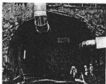
図 6 坑内設置型防音扉図
