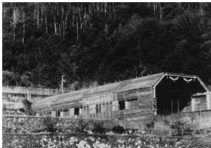
図 4 長さ 49 m の入口緩衝工
