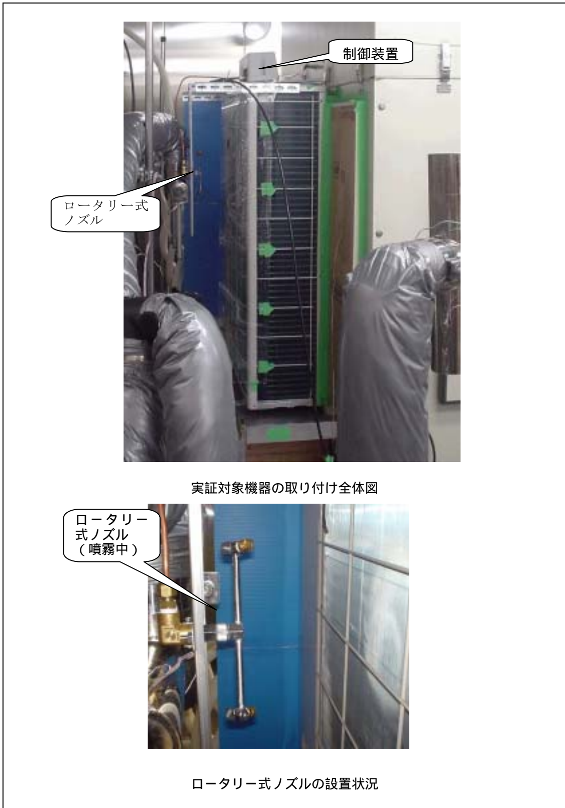
図 1 - 2 実証対象機器の設置状況
