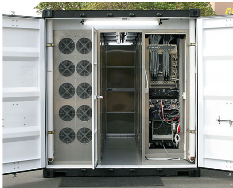
データセンターのモジュール化
