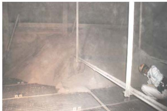
图4 脱硝装置入口部的灰堆积状态 引用: 四国综研新闻, Vol.9, 2009
