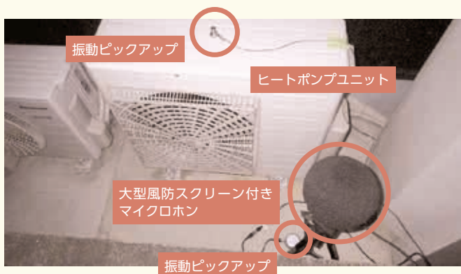
機器近傍（測定地点④）の測定機材の設置例
