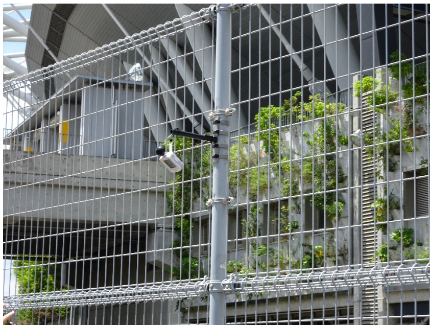
図 4-1 (g) 携帯型 フェンス利用設置例
