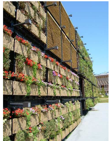
大規模壁面緑化「バイオラング」 （写真提供：公益財団法人都市緑化機構）
