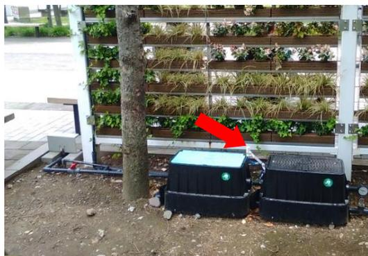
図 4.37 雨水センサー
