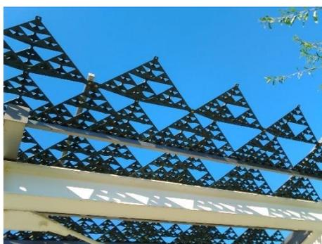
図 4.26 木の葉を模したフラクタル形状の日除け<sup>59</sup>
