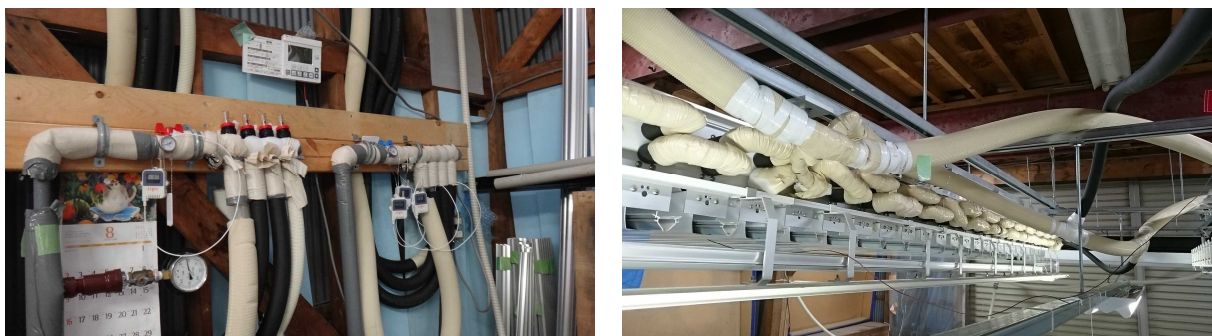
図 6.36 天井冷房システム参考写真（上：ヘッド、下：冷水の送水管）
