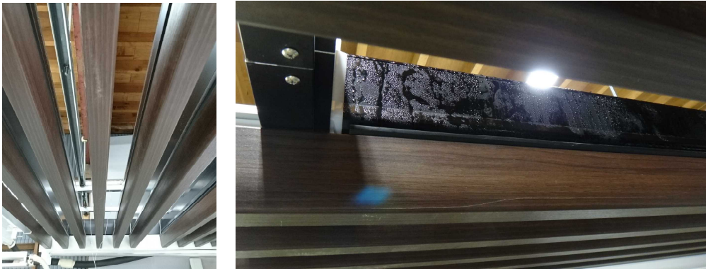
図 6.34 天井冷房システム参考写真（冷却フィン、結露水を受ける化粧ルーバー）
