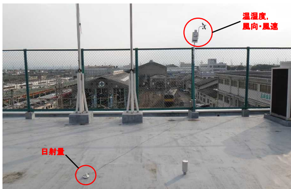
図 6.5 屋外気象の測定点 (高崎車両センター 屋上)
