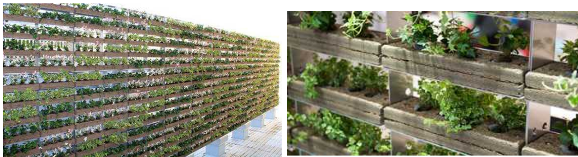
図 2.10 緑化冷却ルーバーの設置イメージ写真（左：全景、右：近景）
