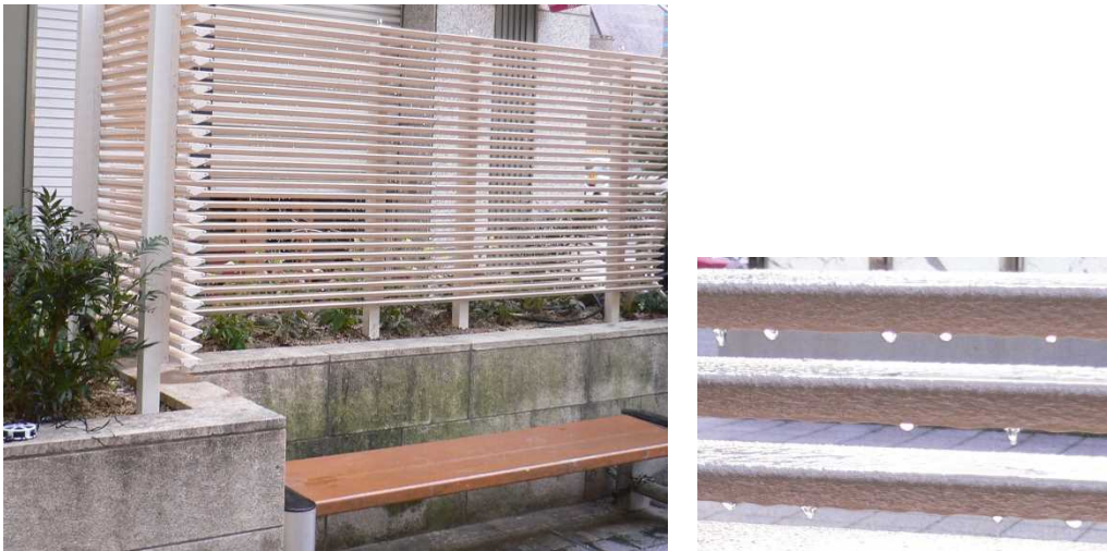
図 2.8 アルミ親水加工冷却ルーバーの設置事例（左 12 ）とルーバー表面の様子（右）
