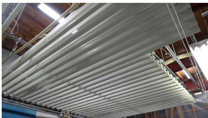
図 2.1 天井冷房システム
