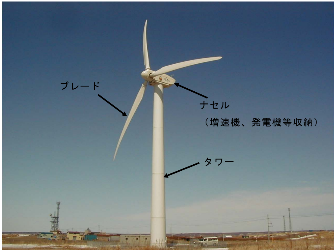
風車を構成する機器の標準的な名称
