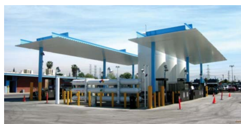
米国のLCNGスタンド（CNG/LNG充填可能）
