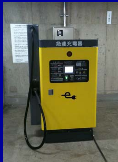
セルリアンタワー 2009年9月設置
