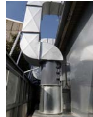
写真3: ファン・ダクト部
