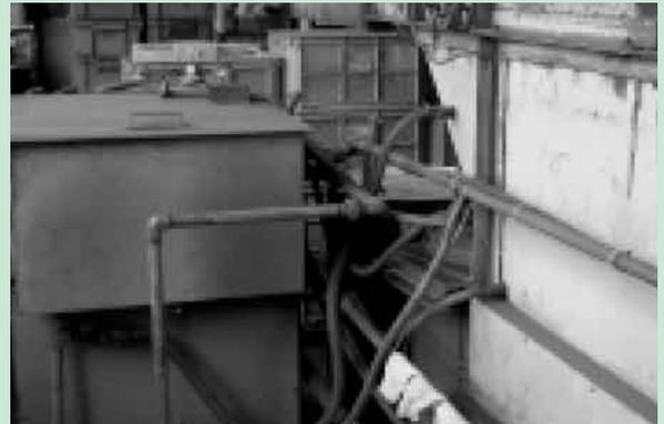
蒸留器の温度、配管を変え、廃液量を改善
