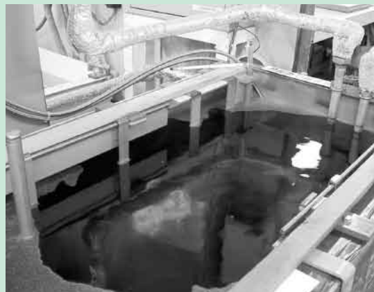
新設したアルカリ超音波洗浄槽
