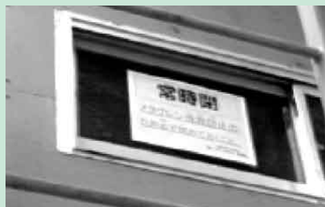
洗浄装置の点検窓常時閉の掲示
