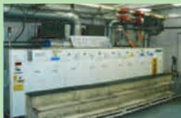
自動2槽式洗浄装置
