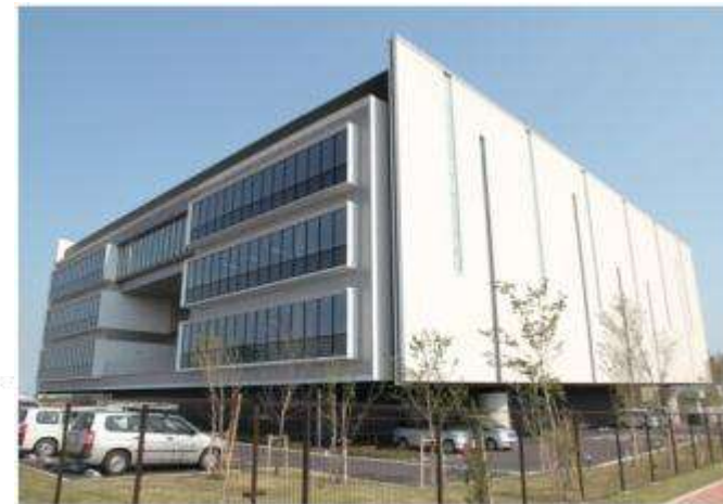
川崎生命科学・環境研究センター 外観
