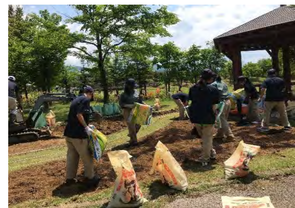
2019 5/17 土壌改良 建設残土のため、石だらけ。除去後、学校オリジナルのもみ殻堆肥を混合ふかふかな土になりました。
