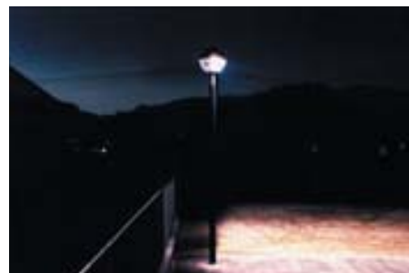
図 - 3 - 8 照明改修事例 (福岡県筑紫野市三笠コミュニティセンター)
