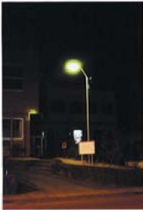
改修前（水銀ランプ）
