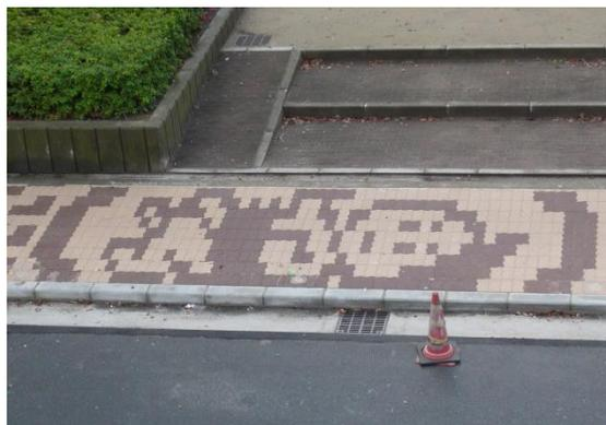
保水性ブロックの設置例で、行政とまちづくりの会の協働により施工した。地域の歴史に因んだデザイン（相撲）に施工されている。市と住民との間で協定が結ばれ、整備された歩道には、住民が打ち水を実施している。
