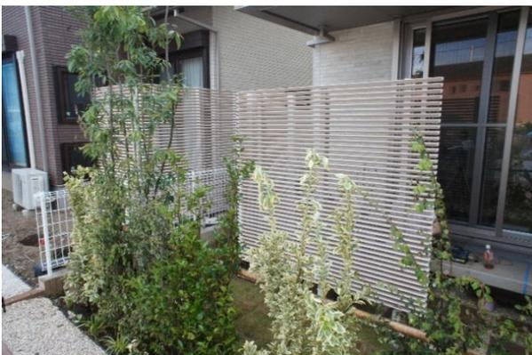
戸建住宅の1階テラスの暑さ対策として冷却ルーバーを設置した例。アルミ製のルーバー表面に親水性・吸水性塗膜を施し、少量の水でルーバー表面温度が効率的に低下する製品が使用されている。
