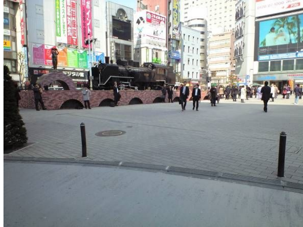
図 3.44 駅前広場での保水性舗装の導入事例 東京都港区新橋駅前
