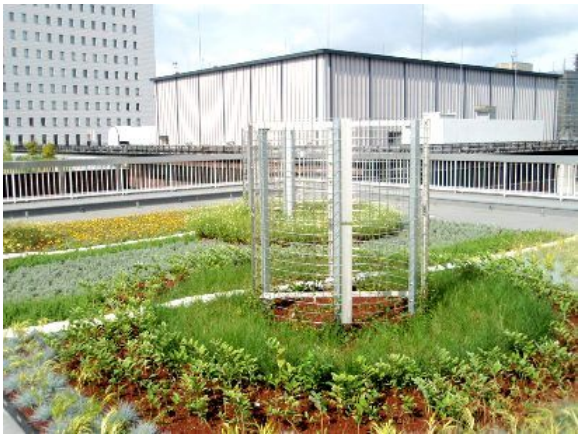
図 3.32 クールシティ中枢街区パイロット事業補助対象例 新東京ビル 資料) 三菱地所(株)提供
