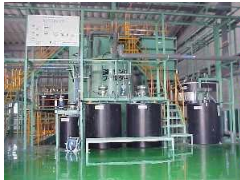
排水処理装置 (西テクノ工場)
