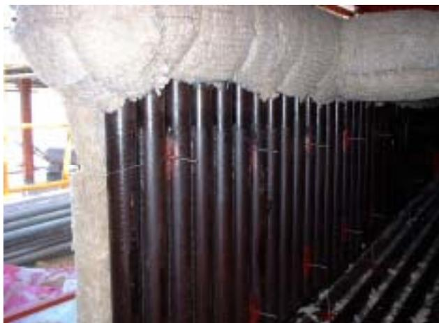
図 4-4-3 ボイラ水管保温例
