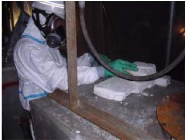
図 4-4-21 電気集じん器保温材等除去例(天井部)
