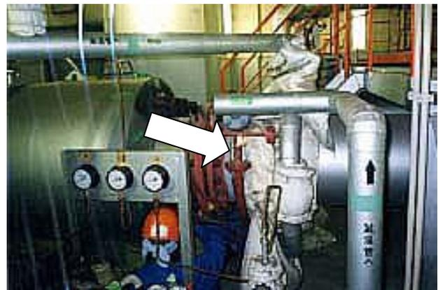
図 4-4-17 蒸気弁保温例
