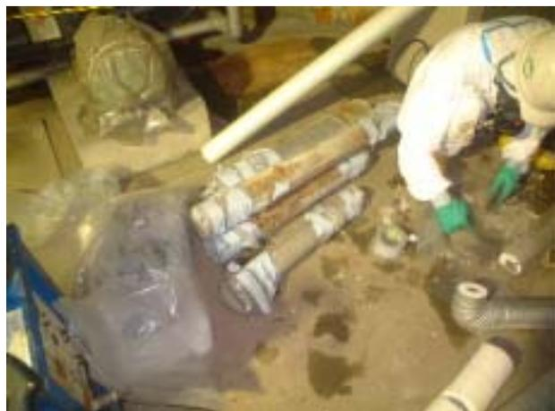
図 4-4-7 配管搬出例(1)
