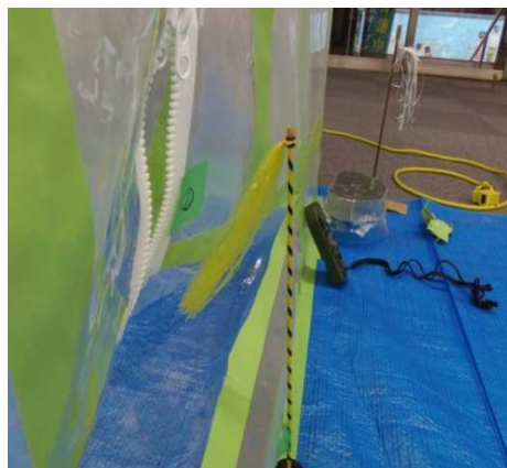
図 3.122 吹流しによる確認
