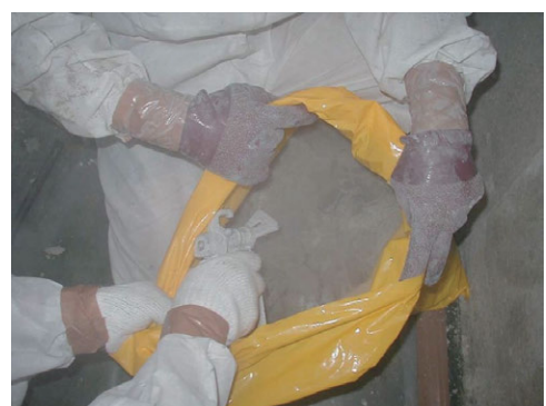
図 3. 67 袋詰めした石綿廃棄物への粉じん飛散防止処理剤を散布
