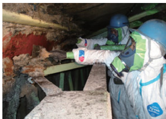
図 3.64 手工具（へら）を使用した石綿含有吹付け材の除去作業
