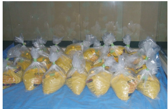
図 3. 69 除去した石綿廃棄物の一時保管
