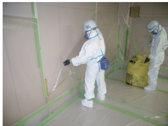
図 3. 72 養生シートの撤去
