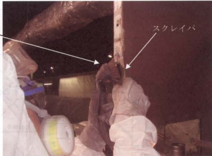
図 3.88 マンホール他 フランジ部のヤーンパッキン交換要領
