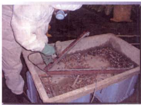
掻き落とし除去作業
