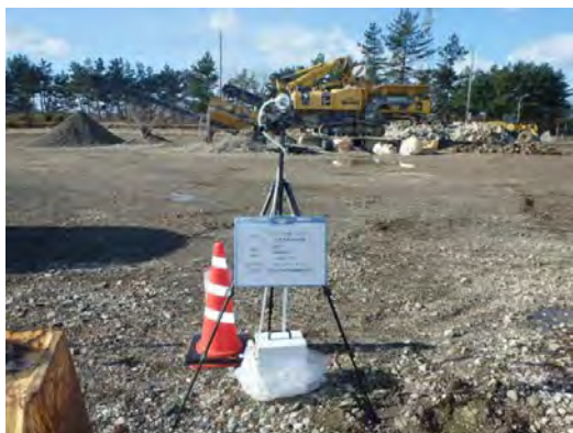
調査地点①(破碎機付近)
