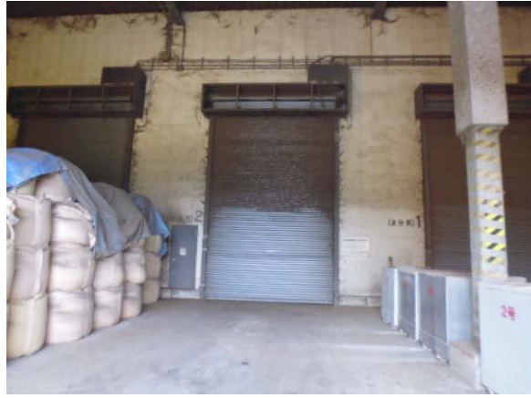
写真6 畜ふん原料投入口
