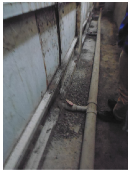
写真2 床面のエアレーション (発酵槽外側)
