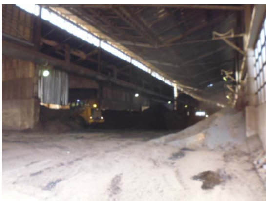
写真1 発酵棟内部の様子
