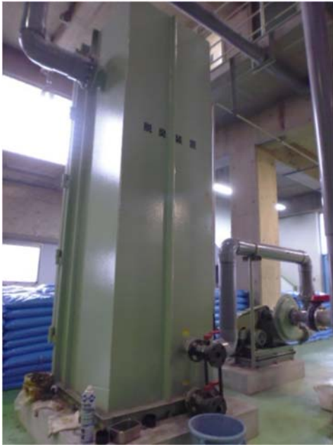
写真5 スクラバー脱臭装置
