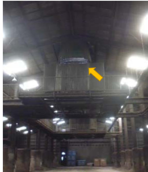
写真7 天井の水洗脱臭塔
