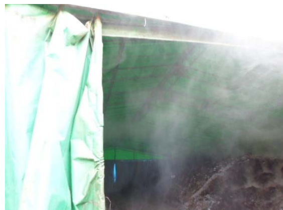
写真8 第1ヤードの搬入口にある消臭剤の噴霧装置
