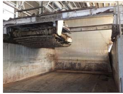
写真6 一次発酵槽の出口側
