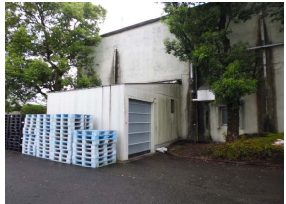
写真3 汚泥乾燥施設の搬入口に設けられた前室
