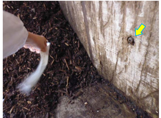
写真3 壁面からの加圧空気孔（右上矢印）
