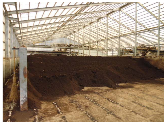
写真4 二次発酵棟（スクリー式の攪拌機）
