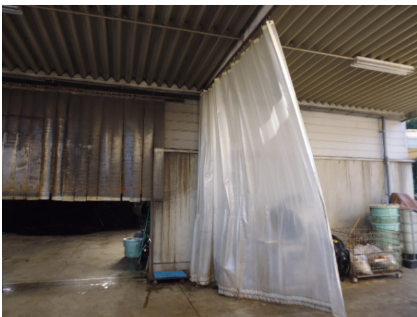
写真4 堆肥棟の搬入口
