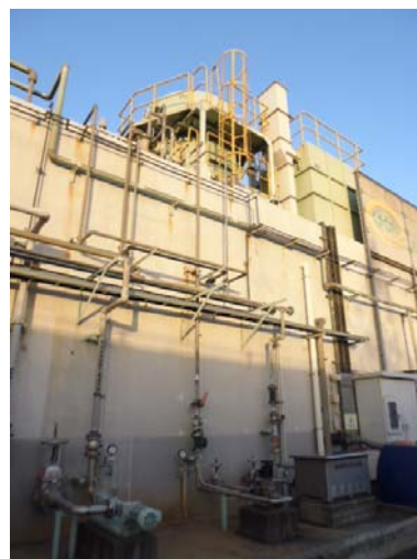
写真7 脱臭後の最終排気口
