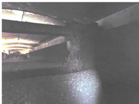
写真4 発酵槽の内部
