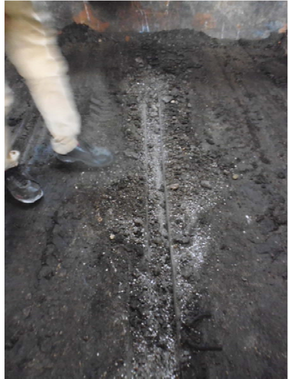
写真6 床面に埋設している通気口
