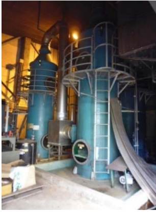
写真5 排ガス処理装置
