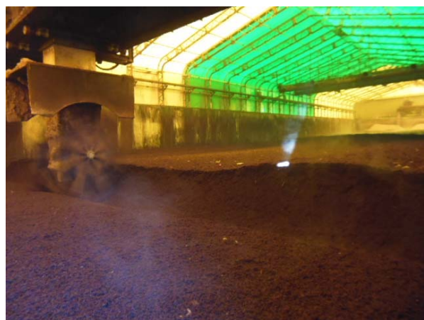
写真2 パドル式攪拌機（後半発酵）
