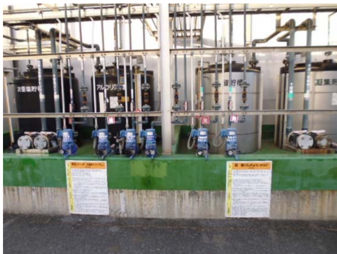
写真6 薬液脱臭装置のタンク
