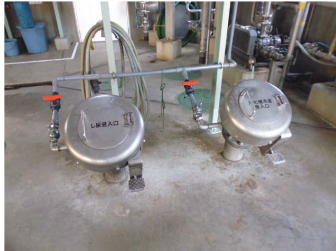
写真3 し尿（左）と浄化槽汚泥（右）の受入口
