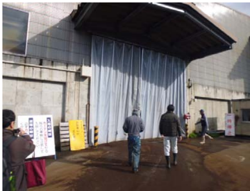
写真3 堆肥棟の搬入口
