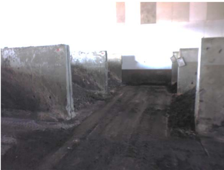
写真1 堆肥棟内の6つの発酵槽
