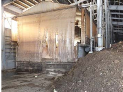
写真5 一次発酵槽の入口側（投入口）
