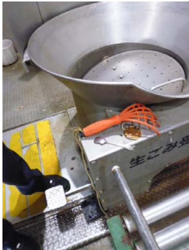
写真2 生ゴミの投入口
