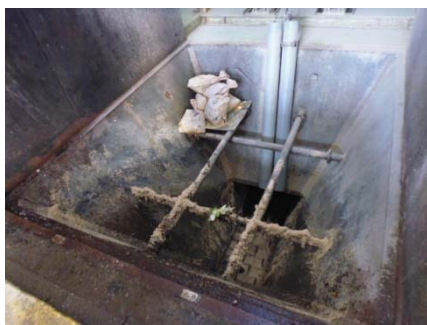
写真 1 原料の投入口
