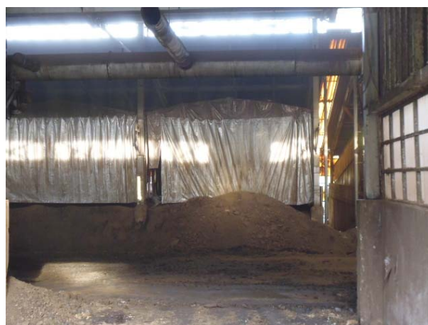
写真4 発酵槽をビニールハウスで覆い吸引している
