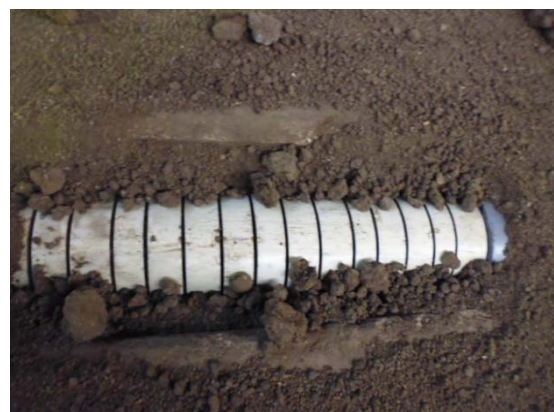
写真2 床面に埋設されたエアレーション用通気口
