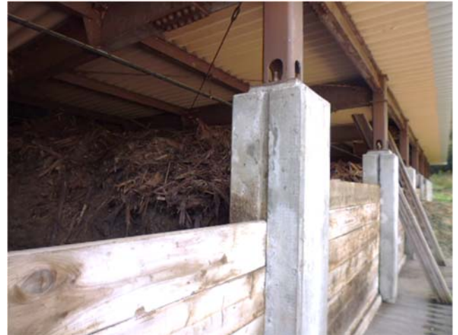
写真6 生物脱臭槽（バーク高さ2.5m）
