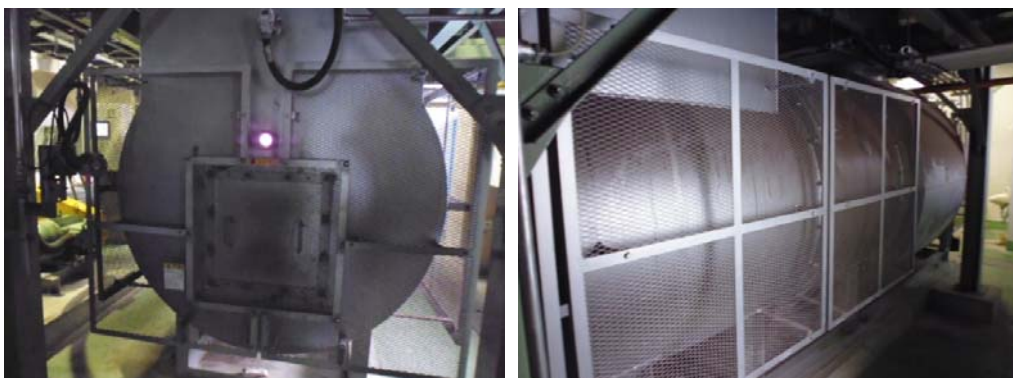
写真4 直接燃焼脱臭装置（正面からと側面から）
