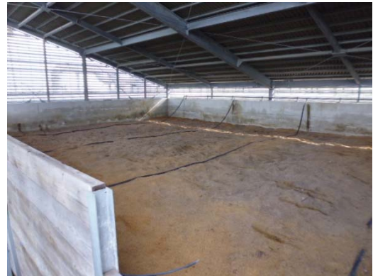
写真6 生物脱臭槽で脱臭処理
