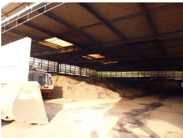
写真5 脱臭棟 (生物脱臭槽)
