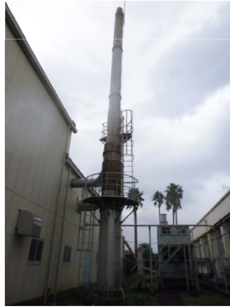
写真6 最終排気口（高さ 20.6m）
