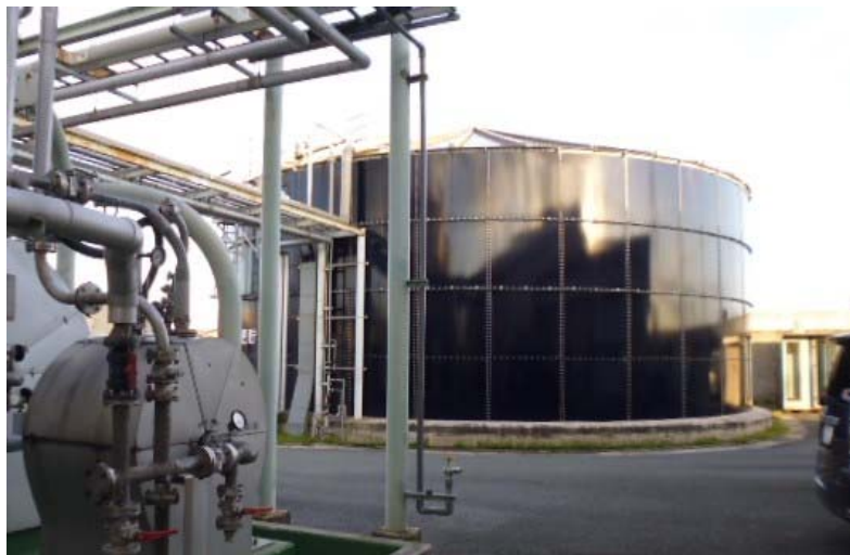
写真 1 液肥の貯留タンク
