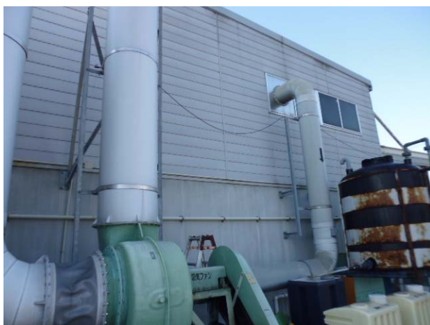
写真6 堆肥棟から排出ガスを吸引（2ヵ所）
