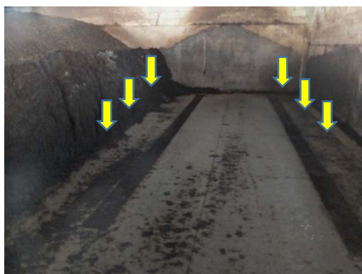
写真3 二次発酵槽床面の通気口
