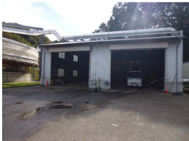
写真5 原料投入棟 (上部から吸引して脱臭処理)
