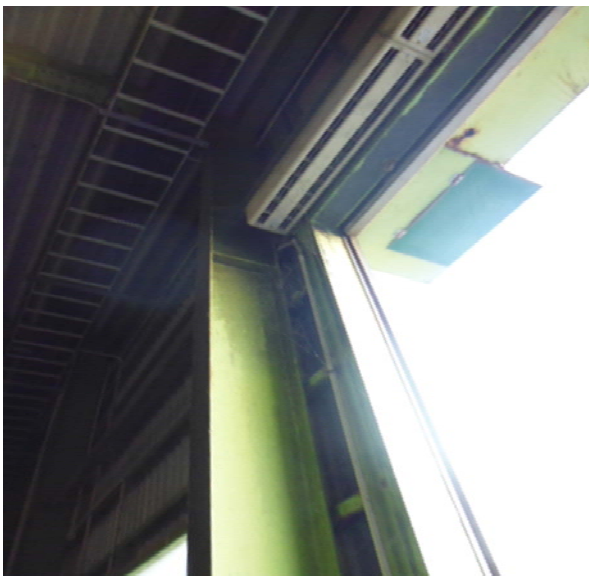
写真5 原料投入棟の搬入口のエアーカーテン
