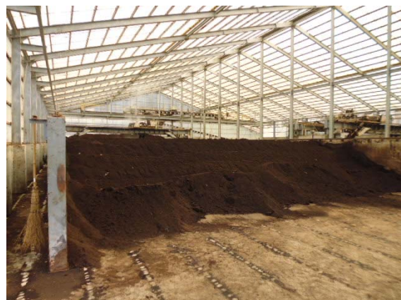
写真4 二次発酵棟（スクリー式の攪拌機）
