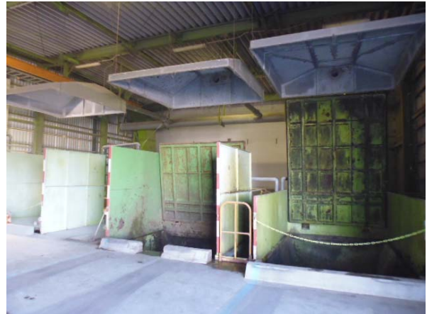
写真4 原料投入口と吸引フード
