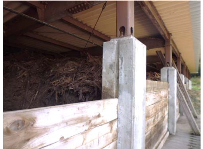
写真6 生物脱臭槽（バーク高さ2.5m）
