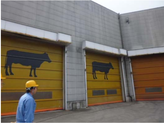
写真5 畜ふんボイラー原料投入棟
