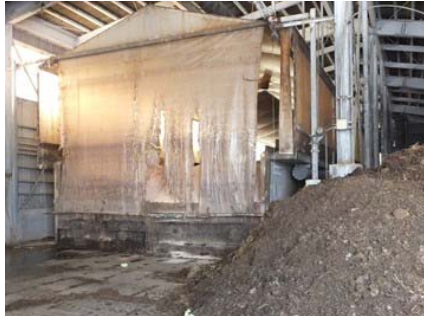
写真5 一次発酵槽の入口側（投入口）
