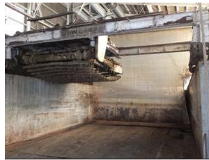
写真6 一次発酵槽の出口側
