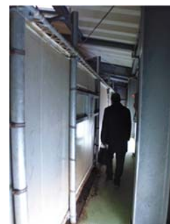
写真5 堆肥棟の中にある発酵槽（左）
