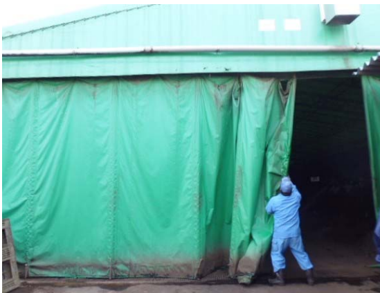
写真7 後期工程（第1ヤード）の搬入口
