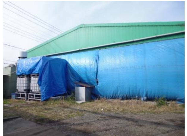
写真9 第1ヤードの脱臭装置 （中央左：生物脱臭槽、左端：活性炭
