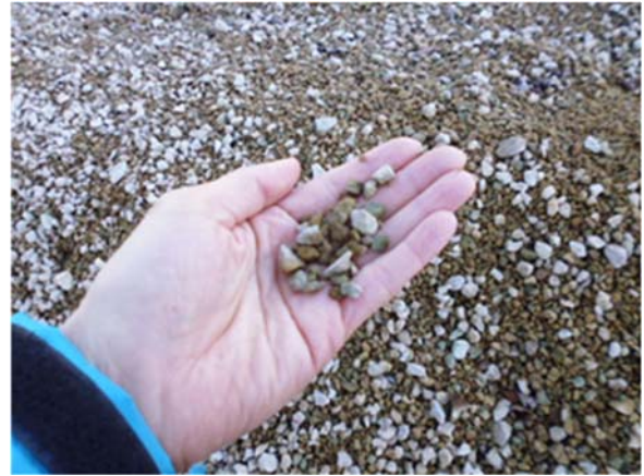
写真7 生物脱臭槽に充填されているゼオライト
