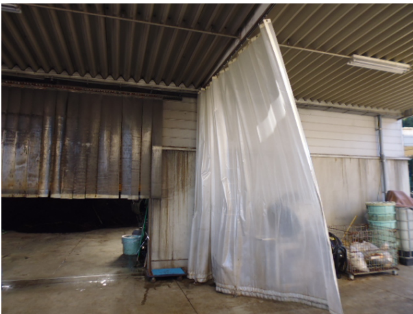
写真4 堆肥棟の搬入口
